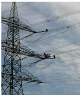
Seit einigen Wochen kann man an der Hochspannungsleitung, die vom Umspannwerk Redwitz durch das Steinachtal in Richtung Mannsgereuth führt, Montagearbeiter in schwindelerregender Höhe beobachten. Hintergrund der Maßnahme, die vom Netzbetreiber TenneT durchgeführt wird, ist eine Verstärkung der Übertragungskapazität durch eine Umbeseilung der bestehenden Freileitung.
